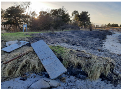
8. februar 2024. Eksisterende dige retableret.
