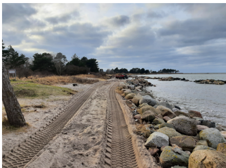
31. januar 2024. Arbejde i gang.
