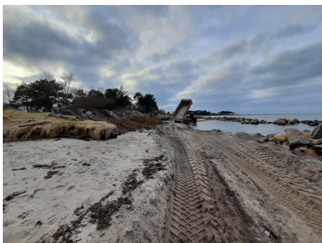
31. januar 2024. Arbejde i gang.
