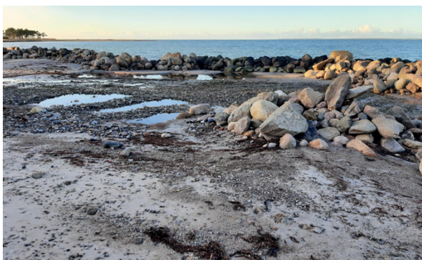
8. februar 2024. Ændringer af bølgebrydere til sammenhængende hård kystsikring.
