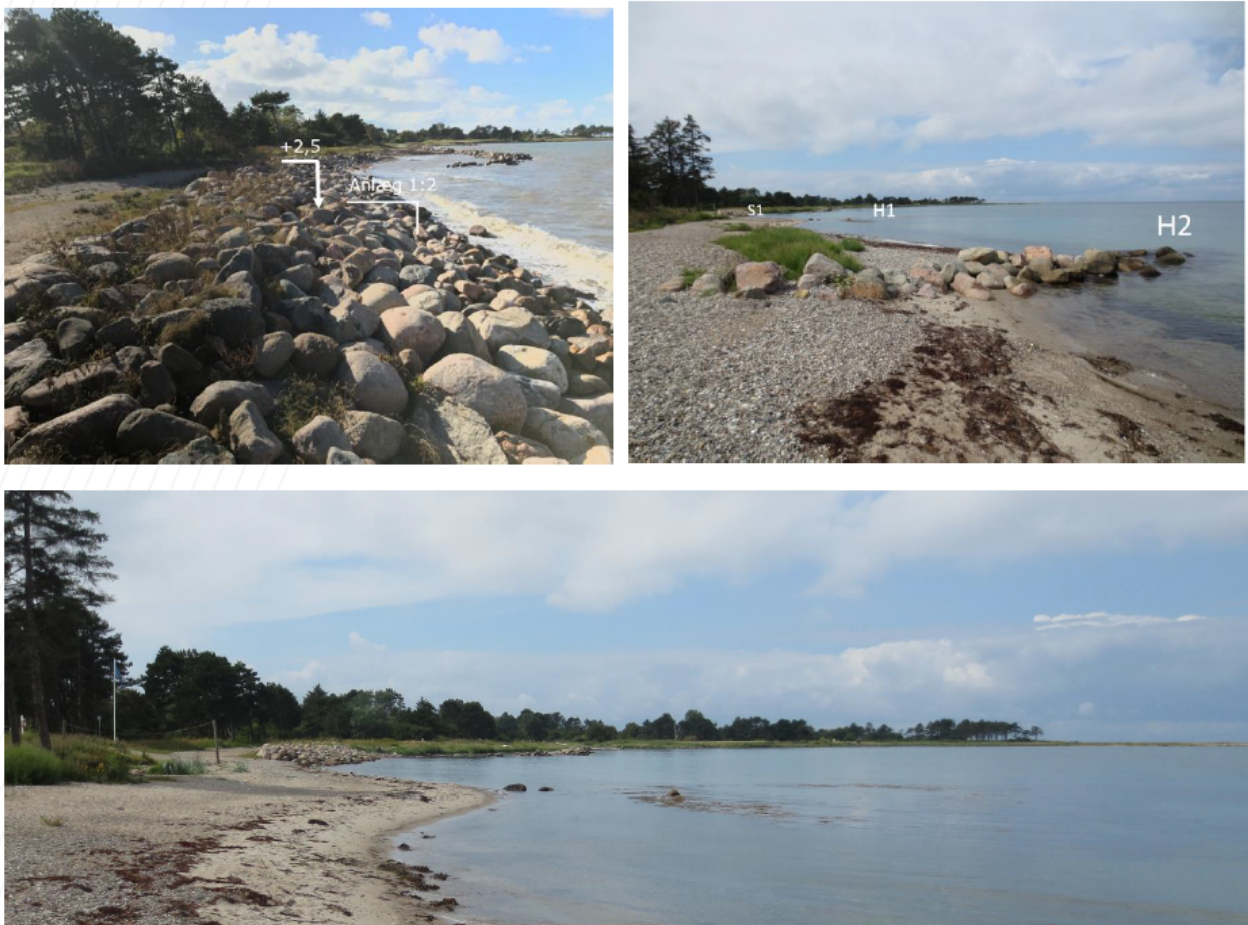
Figur 5.4: Billede 1: Skråningsbeskyttelse S1 i forgrunden med bølgebryder B7, B6, B5, B4, B3, B2 i baggrunden. Billede 2: Høfderne H2, H1 og skråningsbeskyttelse S1 i baggrunden. Billede 3: Høfde H1 i forgrunden og skråningsbeskyttelse S1 samt bølgebrydere i baggrunden. Billeder fra 2016.
