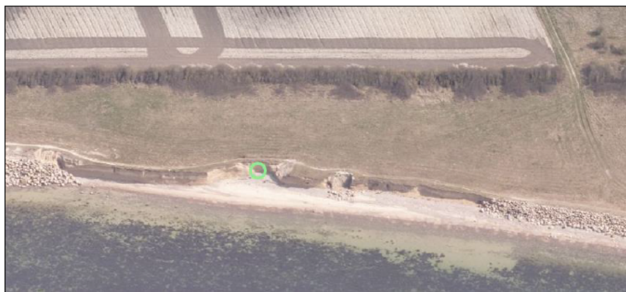
Figur 2.28: Erosion i den vestvendte klint. Området er privat-ejet.
